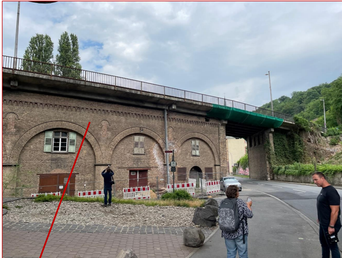
für motorisierten Verkehr gesperrte Ostrampe mit historischen Gewölben
